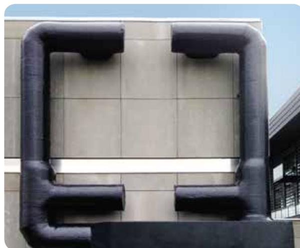
Beim Verbinden der Stücke ist eine Überlappung von nur 20 mm ausreichend, um die isolierten Leitungen absolut wasserdicht zu verkleiden.
